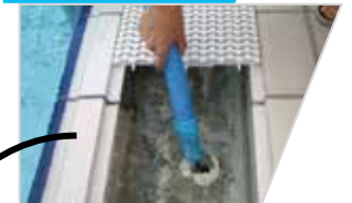
2. Pumpe für den Hauptfilter
